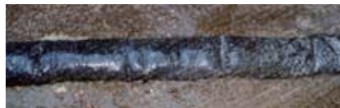
布設した埋設地線の上にパーコムをのせ散水する
