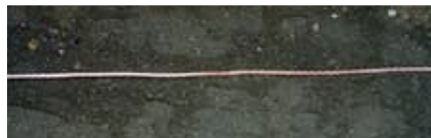
掘削溝に埋設地線を布設する
